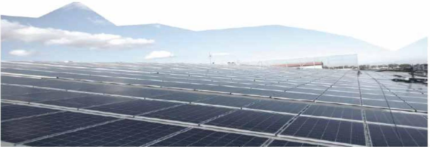
En la Sucursal de Curridabat tenemos instalados 108 paneles solares y 3 inversores que generan una potencia de 34,56 kWp.
